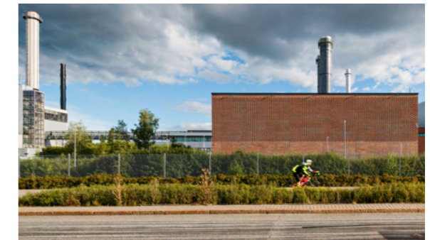
Pompgebouw voor restwarmte, Finland (door Virkkunen & Co)
