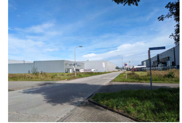
Tilburg - Katsbogten Logistiek landgoed - Bestaand
