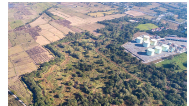
Beschermingsstrook en bufferzone, Thailand
