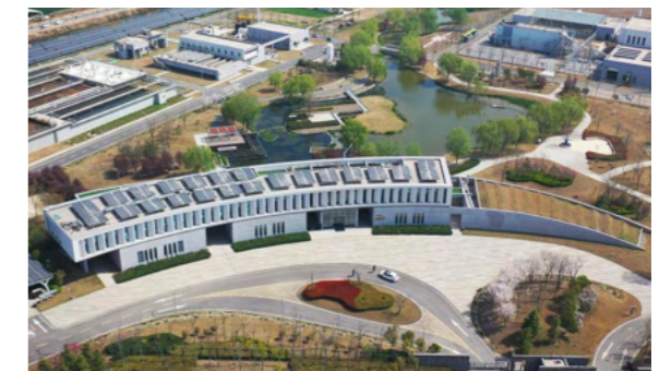
Rioolwaterzuivering verbetert kwaliteit rivierwater
