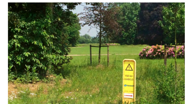
Waarschuwingsteken voor ondergrondse kabels
