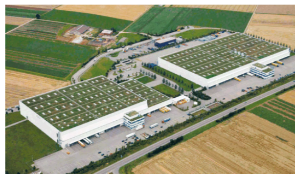
Logistiek centrum met groene daken
