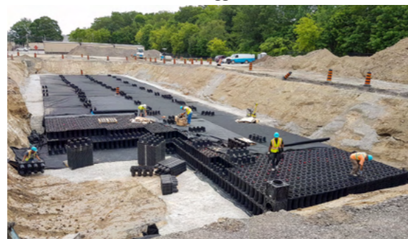
Geotextiel voorkomt aardeophoping
