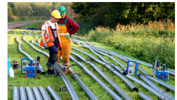
Kabels en leidingen worden uitgelegd
