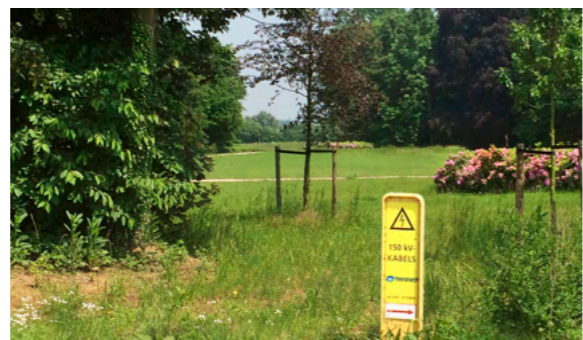
Waarschuwingsteken voor ondergrondse kabels
