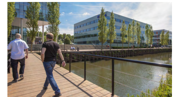
Voetgangersbruggen op het bedrijventerrein, Park 2020, Hoofddorp
