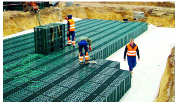
Kratten voor waterretentie neerleggen
