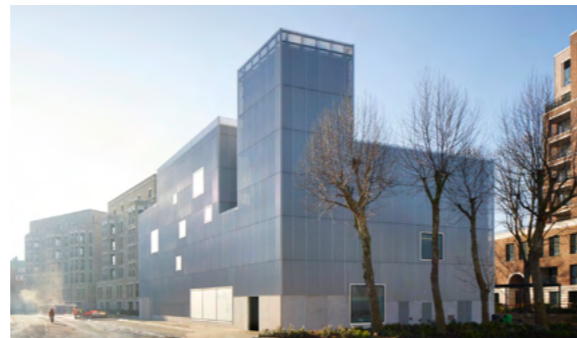
Energiehub in kwalitatief gebouw, Londen (door Morris+Company)
