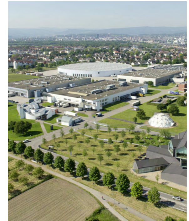
Volume bouwt op vanaf de weg, Vitra Campus, Basel
