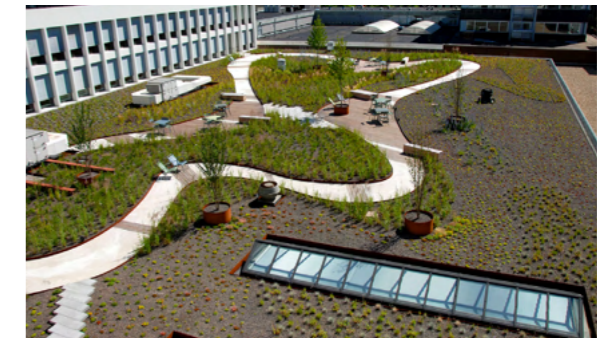
Waterretentiedak als ontmoetingsruimte
