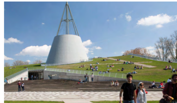
Park op het dak van de bibliotheek, TU Delft (door Mecanoo)
