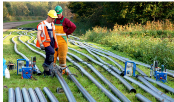
Kabels en leidingen worden uitgelegd
