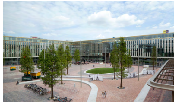
Entrees aan een centraal plein, Amsterdam (door Karres en Brands)
