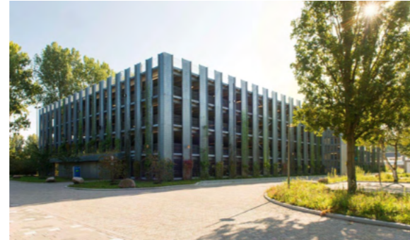
Tijdelijk modulair parkeergebouw, TU Delft
